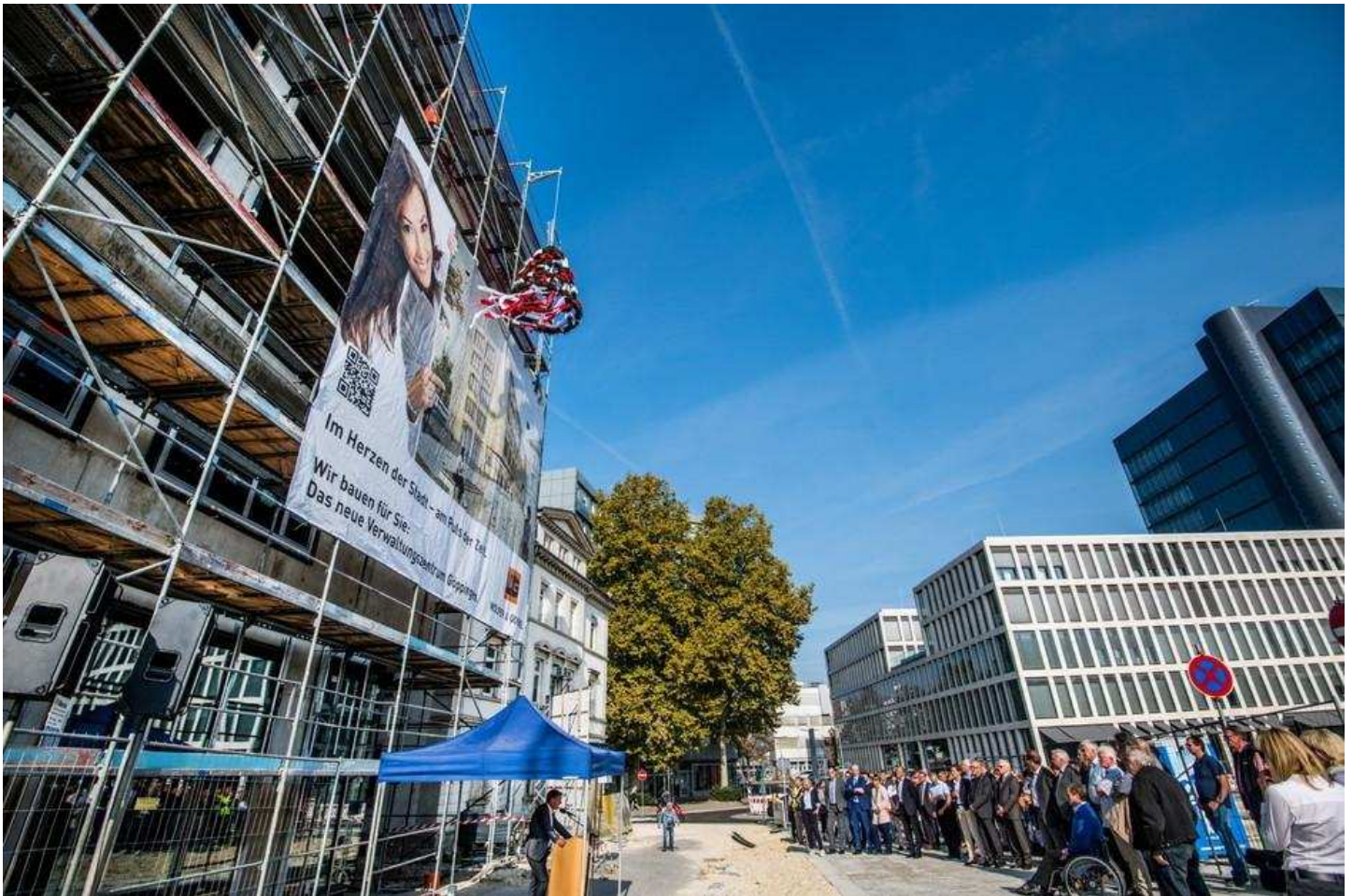
Das städtische Verwaltungszentrum am Bahnhof ist im Rohbau fertig. Gestern wurde gefeiert. © Foto: Giacinto Carlucci
