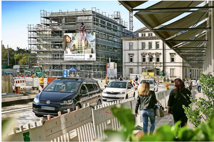
Der Rohbau des neuen Verwaltungszentrums am Göppinger Bahnhof ist fertig. Foto: Horst Rudel
